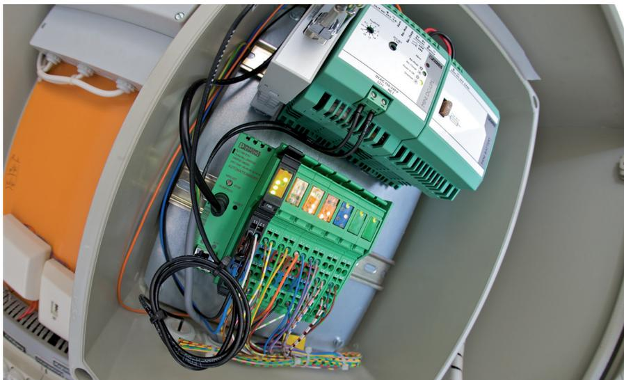
**Bild 3.** Durch verschiedene Ein- und Ausgänge sowie Funktionsklemmen lässt sich der Inline Controller ILC 150 ETH an die jeweiligen Anforderungen der Applikation anpassen
